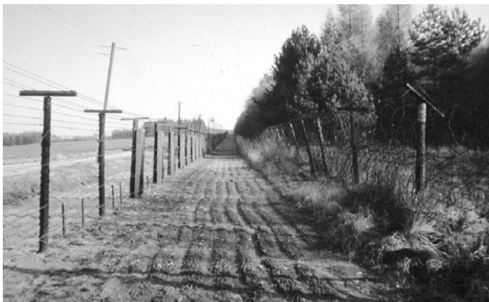
Signální stěna a kontrolní pás železné opony na Příčkách u brány uzavírající cestu na Nový hrádek, 80. léta 20. století. Poslední zachovalý úsek je u obce Čížov. Foto: Petr Lazárek. Zdroj: Archiv Správy NP Podýjí.
