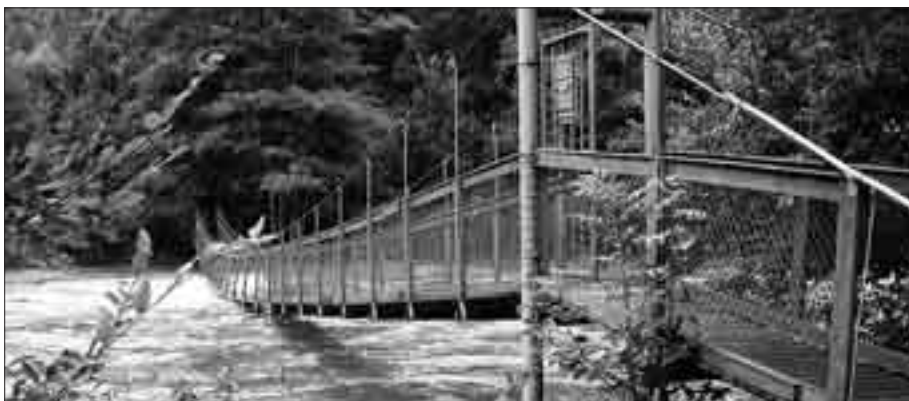
Lávka v Zadních Hamrech těsně před stržením (13.8.2002, 18.10 hod.)
