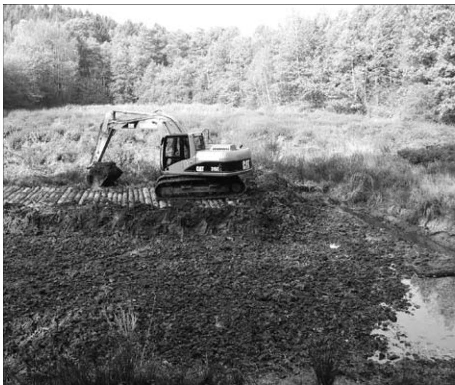
Práce na odbahnění rybníka v říjnu 2005
