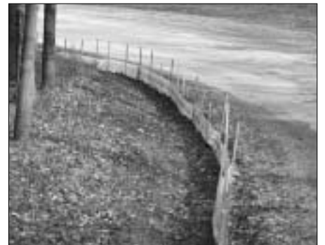
Zábrany tzv. žabochody podél silnice do Žižova
